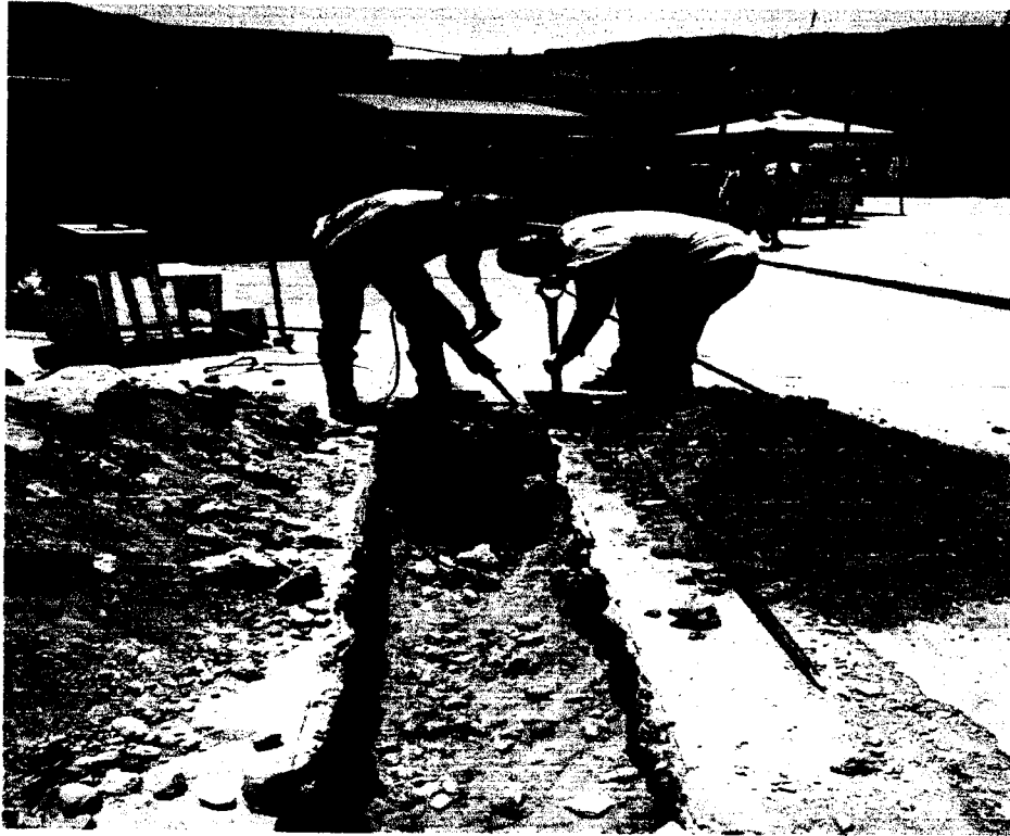
CORTE DE LOSA PARA INSTALACION ELECTRICA ANTES DE MUELLE
